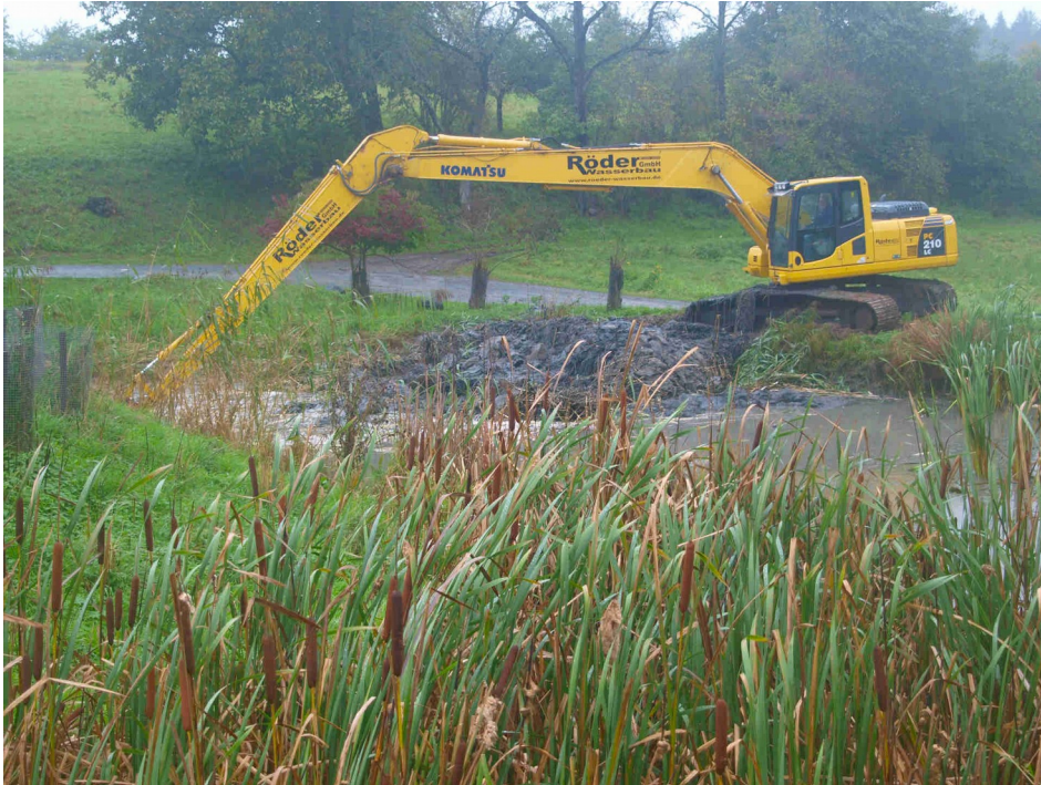
Abb. 10: Beispiel Renaturierung mit Baumaschinen Foto:Wolfgang Feiß / BUND Seeheim-Jugenheim)
